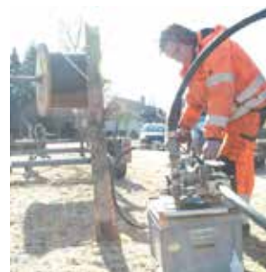
Blåsning av fiberkabel.
